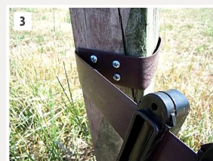
Beginbevestiging met vier schroeven en sluitringen.
