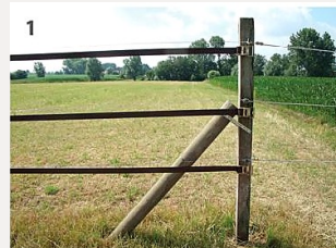
Stevige eind- en hoekpalen nemen de trekkraft op.
