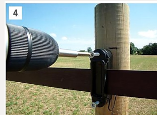
Bevestig iedere houder op dezelfde afgetekende hoogte.
